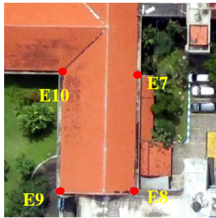
Gambar 7. Gedung C Teknik Elektro
