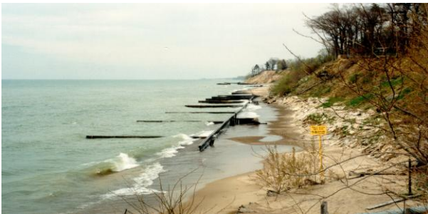
Gambar 13 Bangunan Pelindung Pantai (Groyne)
