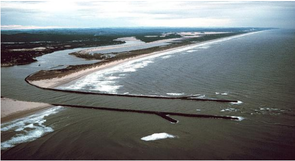
Gambar 12 Bangunan Jetty Untuk Melindungi Muara dan Pantai
