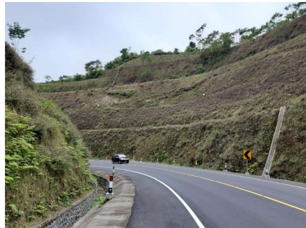
Gambar 2. Kondisi Eksisting STA 0+275
