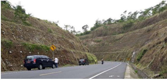
Gambar 4. Foto Lapangan Lereng Galian dengan Perkuatan Soil nailing
