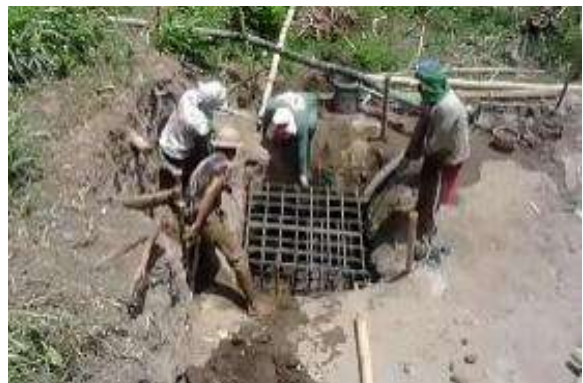
Gambar 8. Pemasangan Footplate
