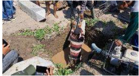
Gambar 6. Memposisikan Mini Pile
