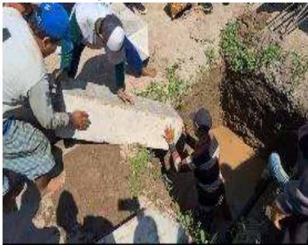
Gambar 5. Memasukkan Mini Pile
