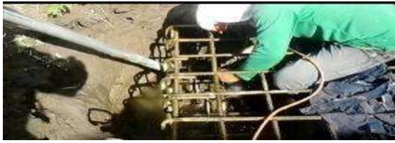
Gambar 9. Tahap Mengikat dan Mengelas
