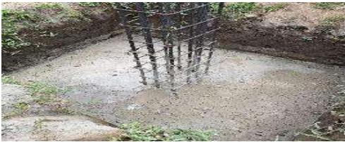
Gambar 10. Tahap Pengecoran
