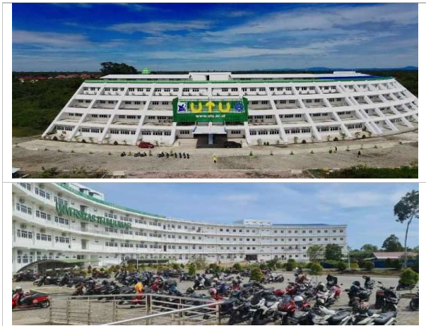
Gambar 1. Kondisi Eksisting Gedung Terintegrasi UTU
