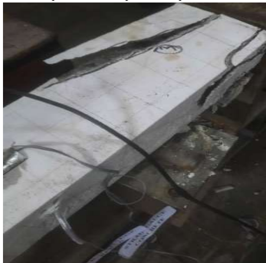
Gambar 7. Pola Retak Spesimen Kolom A2-2L
