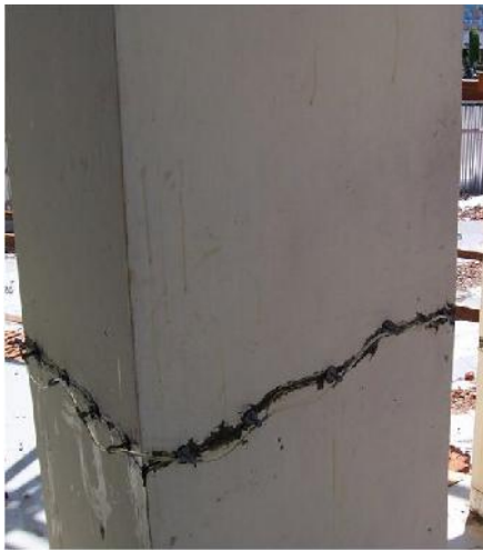
Gambar 9. Perbaikan kolom beton dengan cara epoxy injection
