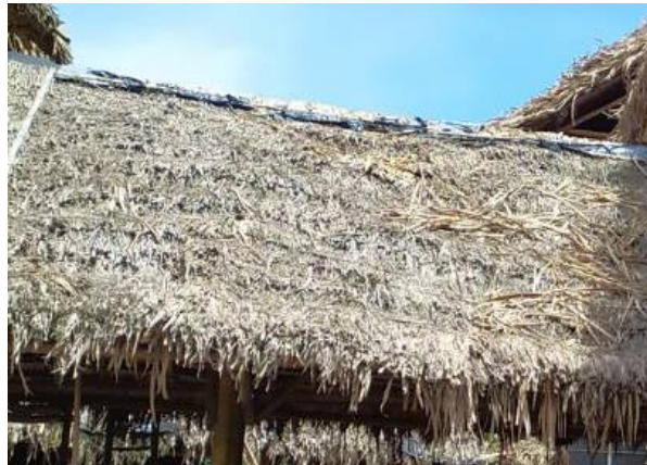
Gambar 4. Material Atap Gudang Atag tampak luar
