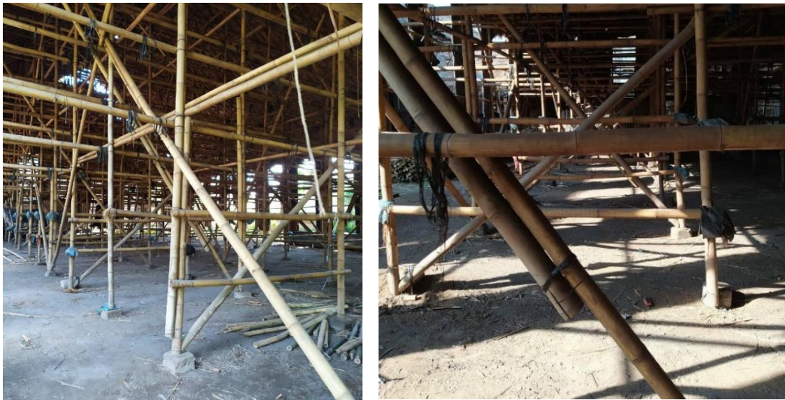
Gambar 7. Struktur kolom Gudang Atag Sumber : Dokumentasi Penulis (2021)
