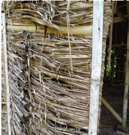
Gambaar 5. Material Dinding Gudang Atag tampak luar
