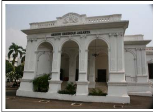
Gambar 5. Tampak Depan Gedung Kesenian Jakarta Sumber: Dokumentasi Penulis (2016)
