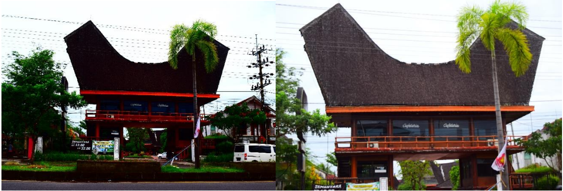
Gambar 1. Tampak Luar Entrance Taman Mangli Indah Jember Sumber : Dokumentasi Penulis (2021)
