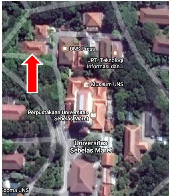
Gambar 5: Foto udara kondisi lingkungan di sekitar bangunan UPT Perpustakaan UNS.
