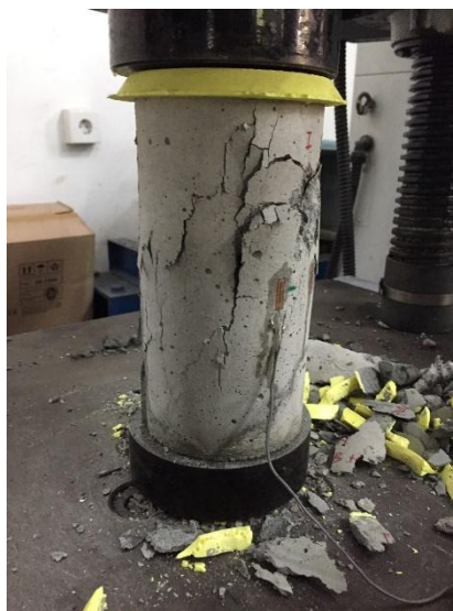
Gambar 2. Pengujian Silinder Beton
