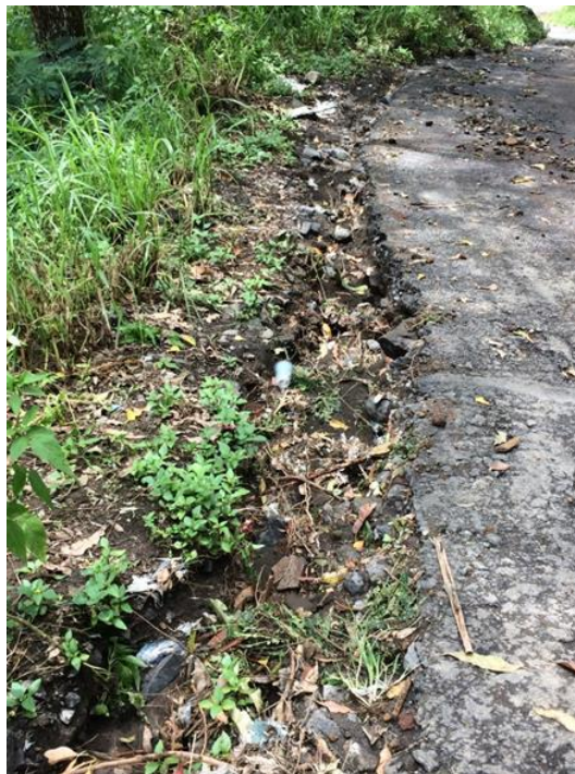
Gambar 4. Retak Horizontal pada Jalan
