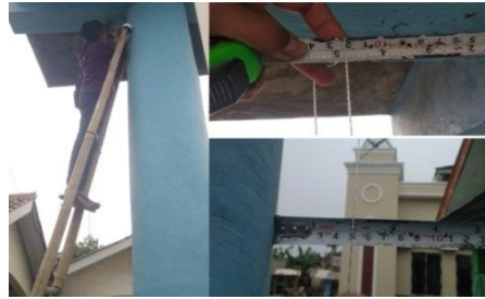
Gambar 3. Pengukuran Kemiringan Kolom dengan Lot Timbangan (Sumber: gambar dokumen pribadi)
