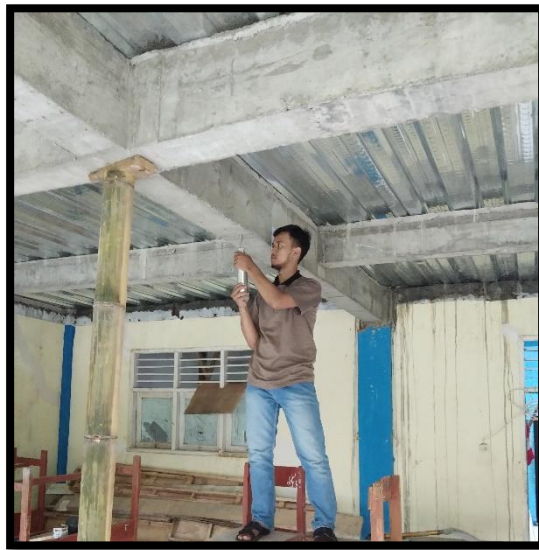
Gambar 1. Pengujian Hammer Test
