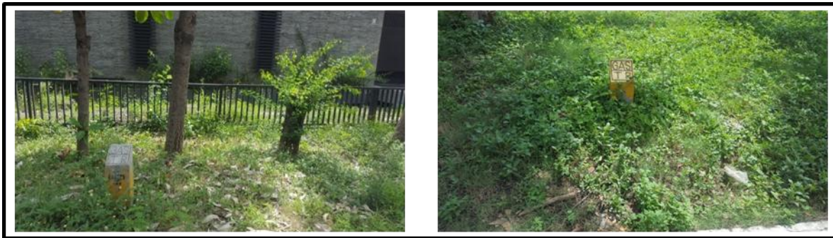
Gambar 3. Tanda Pemasangan Utilitas di Ruas Jl. Ir. Soekarno
