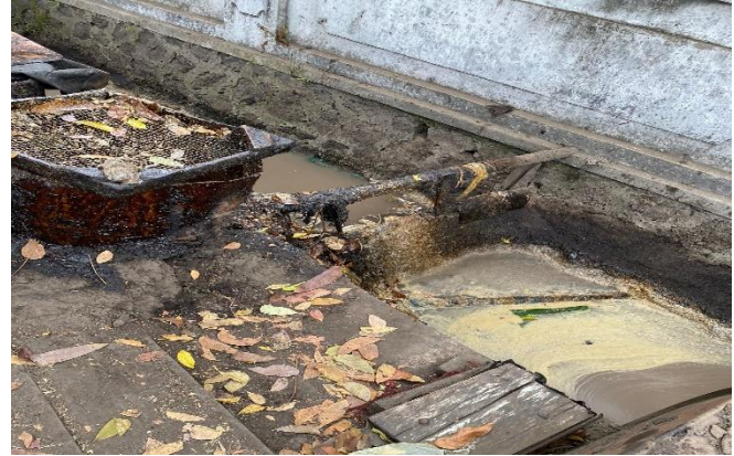
Gambar 3 Saluran Drainase Untuk Pembuangan limbah Industri
