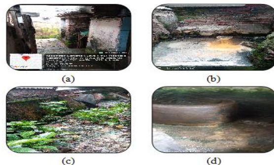
Gambar 2. Kondisi Existing Sanitasi di RW 16 Kelurahan Ampel.
