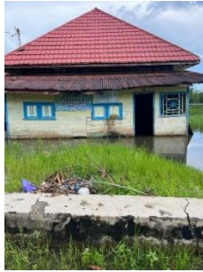
Gambar 16. Bangunan yang terendam banjir dalam jangka waktu lama
