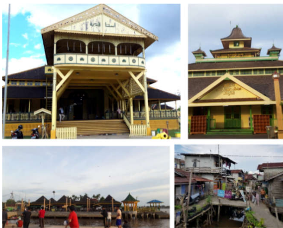
Gambar 9. Kondisi Bangunan-Bangunan pada Kawasan
