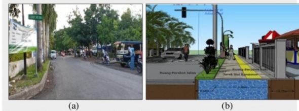
Gambar 3. Dokumentasi Eksisting (a) dan Ilustrasi Rumusan Konsep Desain II pada Fungsi Jalan Lokal (b)
